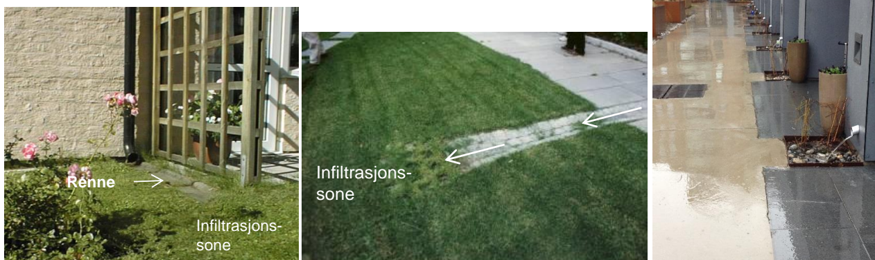
Illustrasjon 19: Bilder som viser eksempler på løsninger for utledning av takvann til infiltrasjon - trinn 1
