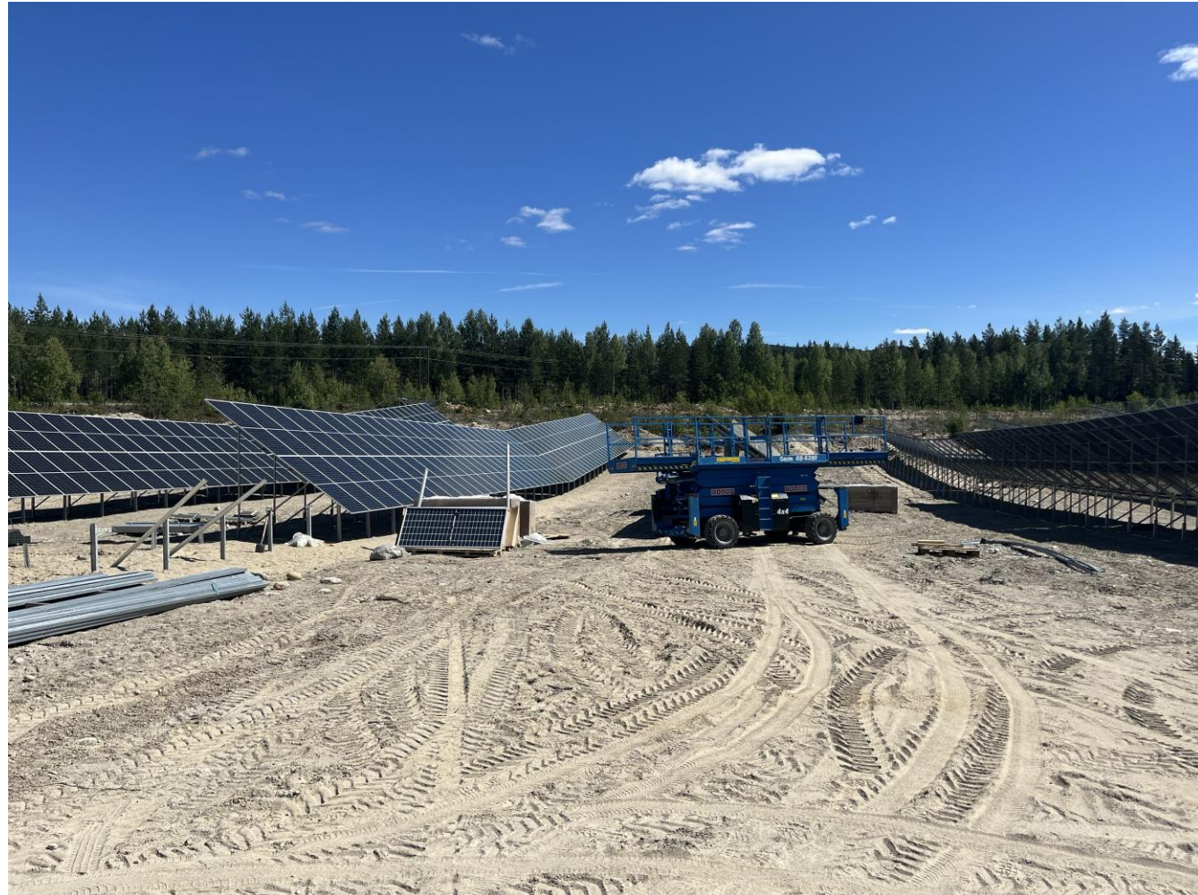
Furuseth solkraftverk under bygging
