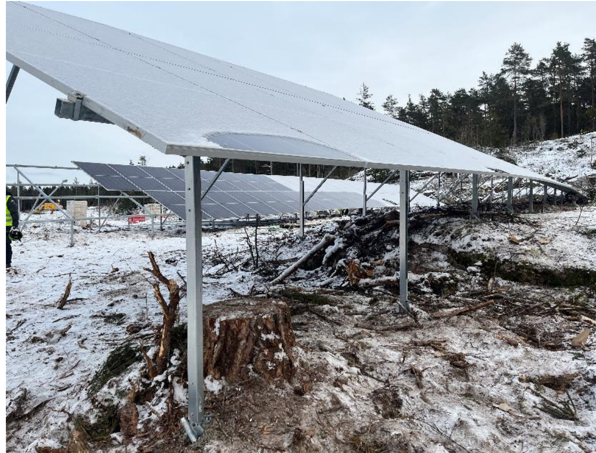
Buer solkraftverk under bygging
