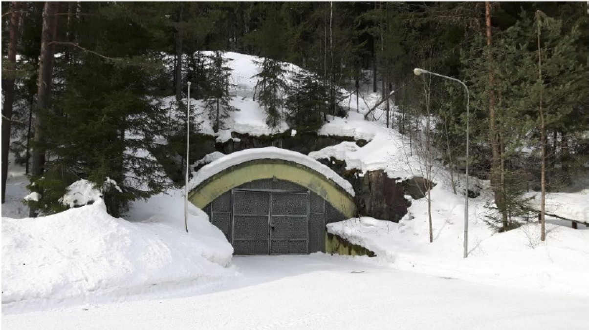
Bilde 1: Det er kun en inngang som leder inn til begge tunnelene.
