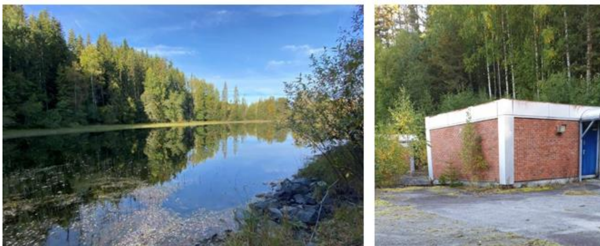
Figur 4-9 Tjorputten og bygg relatert til vannverksdriften
