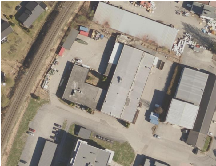
Figur 14 – Næringsbygg og utearealer i Ankersgate 12 besto i stor grad av tak og tette overflater.
