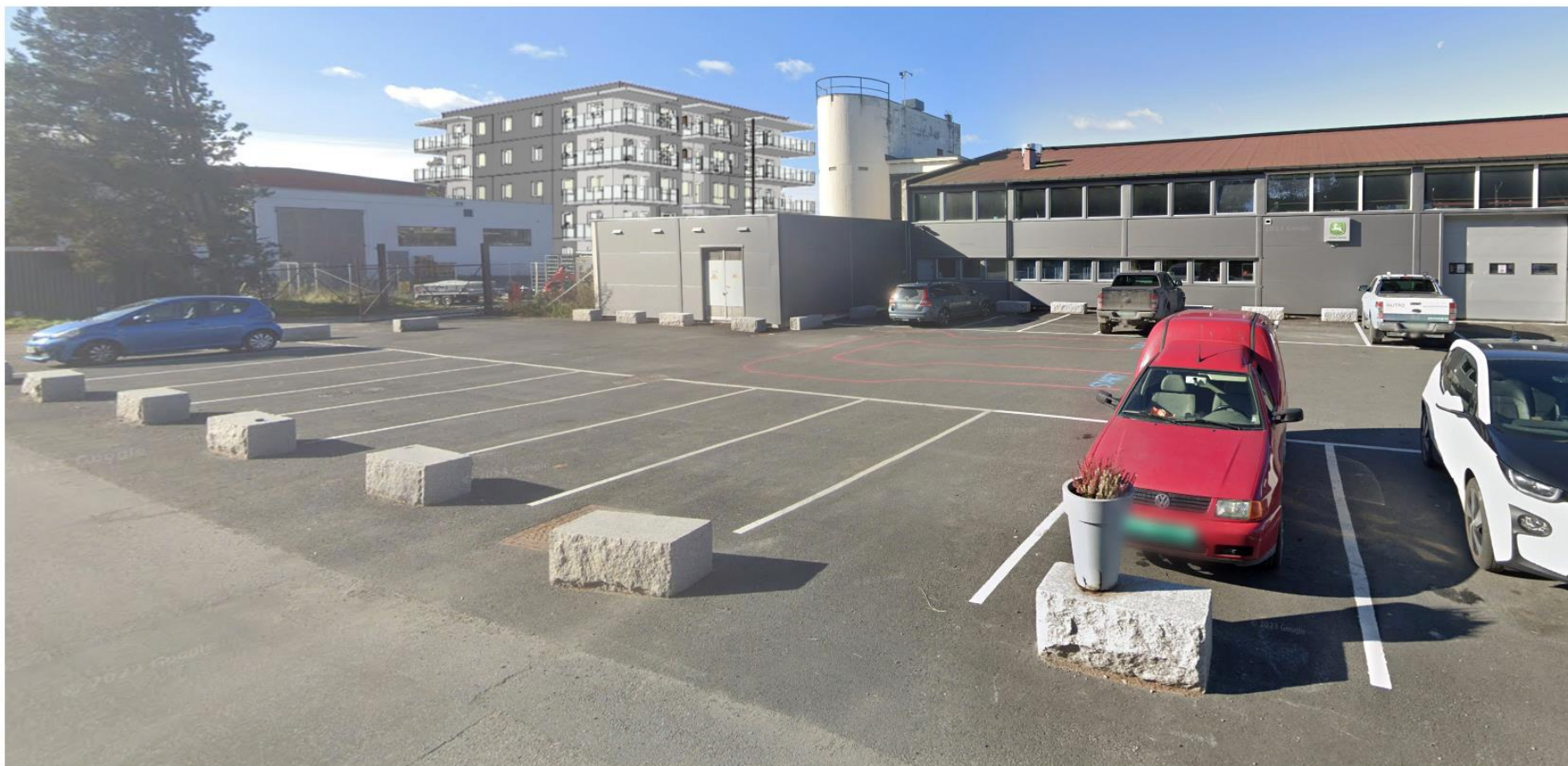
Bilde 1 - Ankersgate 14 sett fra retning Ankersgate 21
