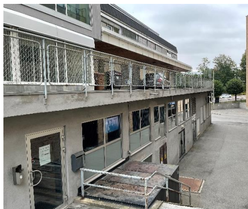
Figur 27: Sentrumspassasjen dagens situasjon
