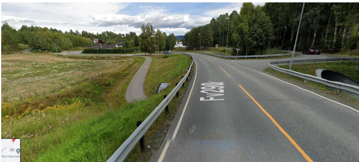
Figur 25 – Infrastruktur til planområdet i Veienkollen. Bildet viser planfri kryssing under fylkesveien vest for planområdet, medgang- og sykkelvei frem til planområdet bak til venstre i bildet. Foto: google maps.
