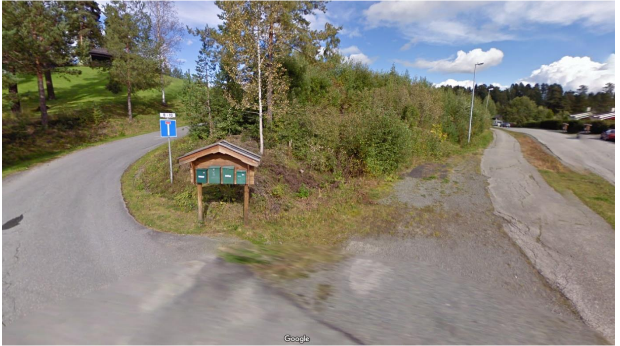
Figur 26 – Infrastruktur til planområdet i Veienkollen. Adkomstvei til eiendommene. Foto: google maps.
