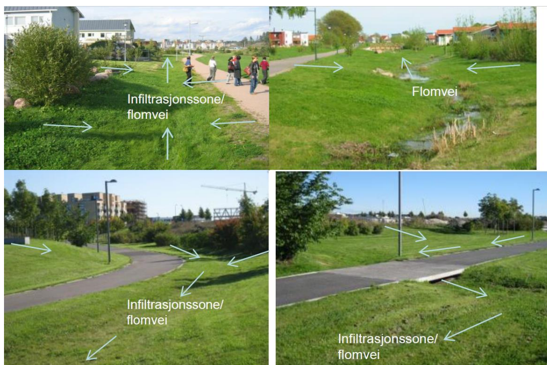
Figur 6 – Eksempel på infiltrasjonssonegrøfter
