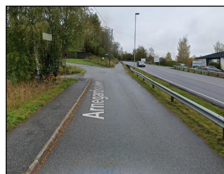
Figur 11: Osloveien til høyre og nedre del av Arnegårdsbakken til venstre.
