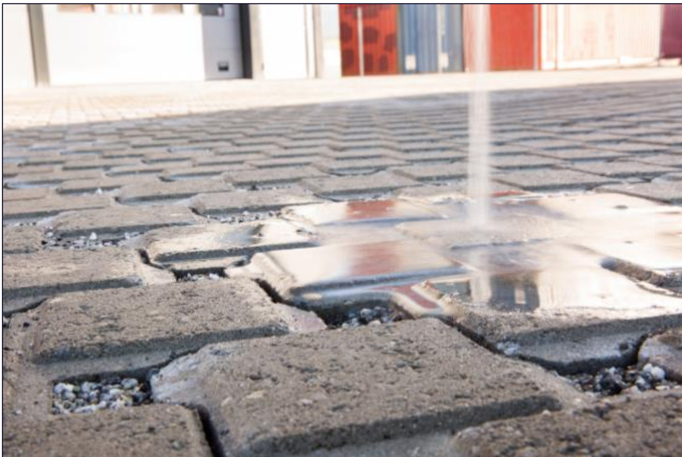
Figur 6 Eksempel på tiltak som fører til infiltrasjon kan være permeable flater, som belegningsstein med gruslommer, eller overflater med grus/pukk. Foto: Asak miljøstein AS
