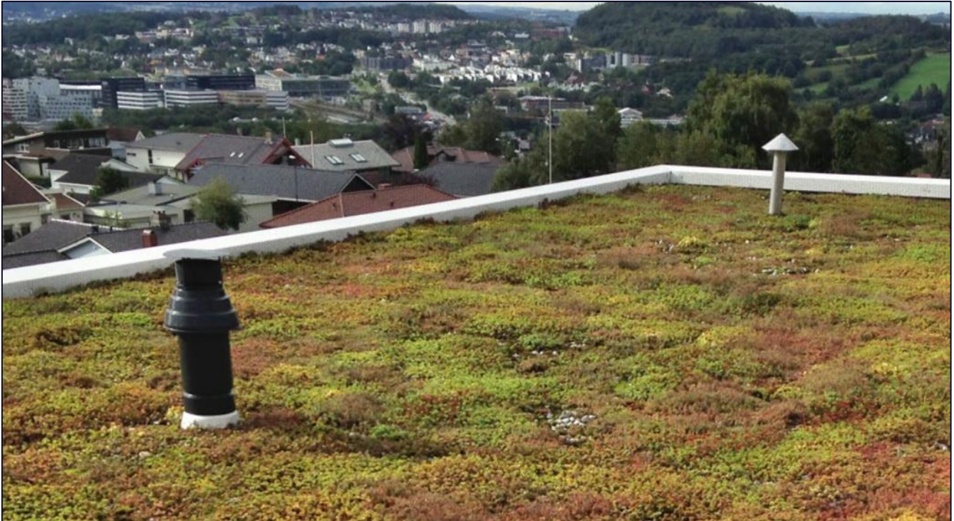
Figur 4 Eksempel på fordrøyende tiltak er grønne tak. Foto: VAV Oslo kommune
