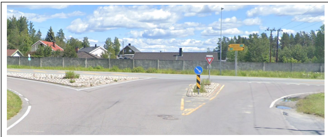
Figur10: Krysset Hensmoveien x E16 (ved Bertil O. Steen), sett fra Hensmoveien. Foto fra google maps
