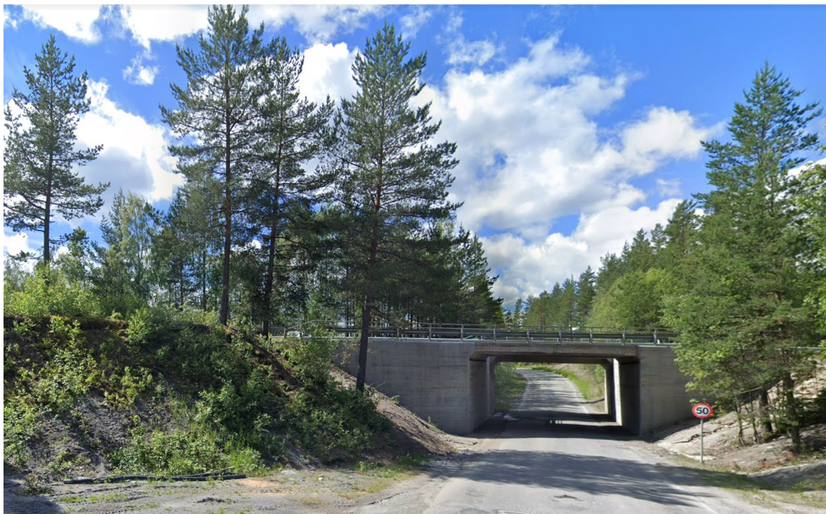
Figur 3: Adkomstveien ut fra Hensmoen nord ved kulvert under E16. Foto i sørvestlig retning fra google maps (2019).
