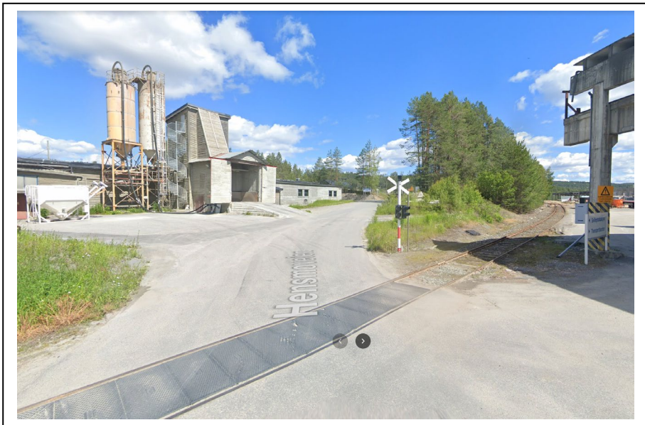
Figur 13: Planovergangen i Hensmoveien. Foto fra google maps (2019).
