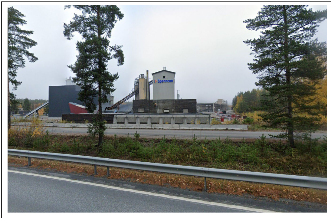
Figur nr. 7.2: Den sørligste delen av Spenncon sin bygningsmasse sett fra E16 mot nord (Google Maps Street View, 2022). Bygningsmassen består av store produksjonshaller med oppstikk over tak med transportbånd og siloer
