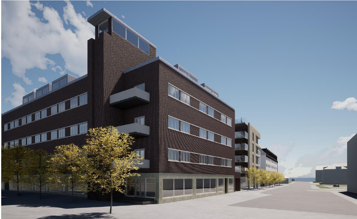
Figur 33 Prosjekt sett fra Søndre torv med Bryggerigården i forgrunnen.
