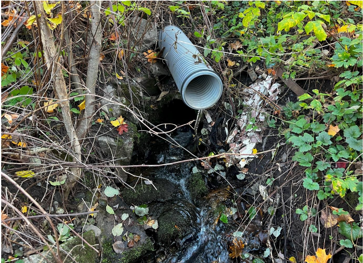
Figur 6. Bekken går gjennom rør under den nordre grusveien i området.
