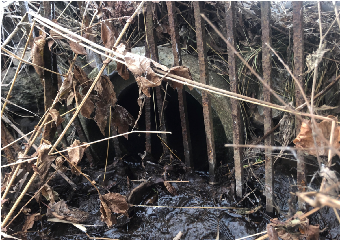
Figur 6-3- Stikkrenne Knestangata, innløp.
