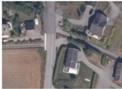
Figur 17 stikkrenne langs Kindåsveien
