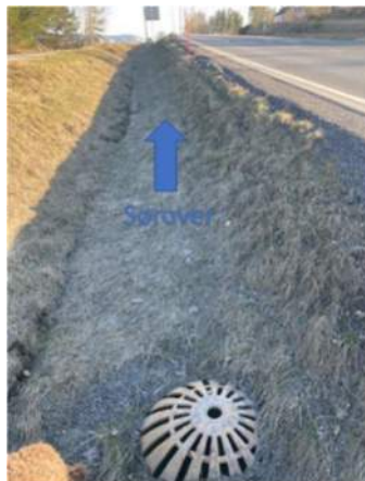
Figur 23 Befaring vår 2023, sør av avkjørsel til fengsel, og nord av avkjørsel, øst av riksvei.
