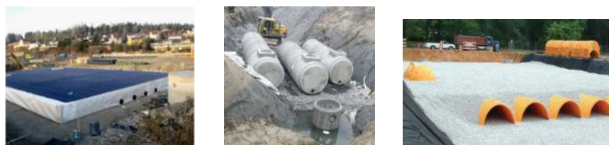
Figur 29: Ulike typer lukkede magasiner. Fra venstre: kassetter, betongrør og overvannskammer.
