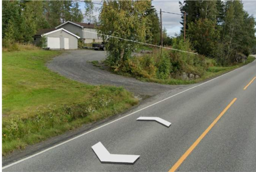
Figur 11 Google earth. Stikkrenne under vei, gjemt av vegetasjon Scalgo viser avrenning langs vei uavhengig av stikkrenne
