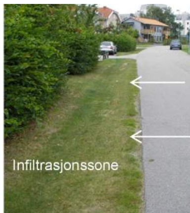
Figur 8: Infiltrasjonssone langs boliggate i Växjö (Foto: Göran Lundgren)
