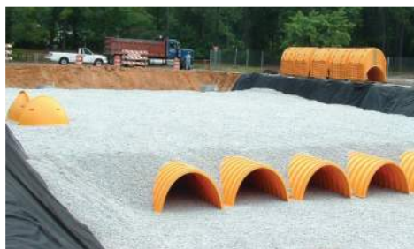
Figur 10: Det finnes flere typer lukkede magasiner, bl.a. kassetter, overvannskammer, betongrør, steinfyllinger m.m.
