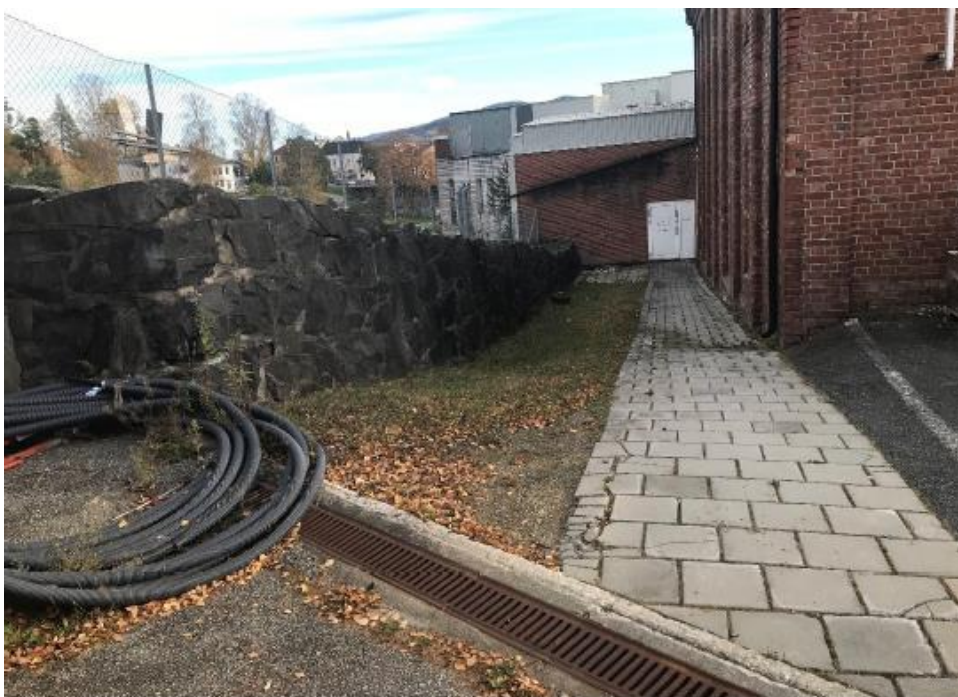
Figur 3: Bildet viser dagens situasjon på baksiden av teglsteinsbygningen retning øst mot Stormarkedet. Kilde: Tronrud Eiendoms dokument “ Vurdering av Elvelangs ” vedlegg 15. Teksten til bildet lyder: Dagens ledemur langs teglsteinsbygning. Muren bør heves opptil to meter i området der plastledningen ligger og kan ligge på samme nivå som i dag den hvite døra.
