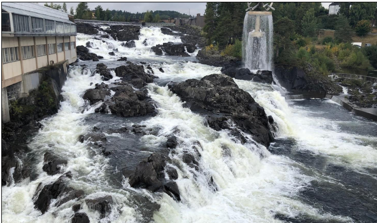
Figur 4: Hønefossen sett fra nedstrøms side ved lav vannføring
