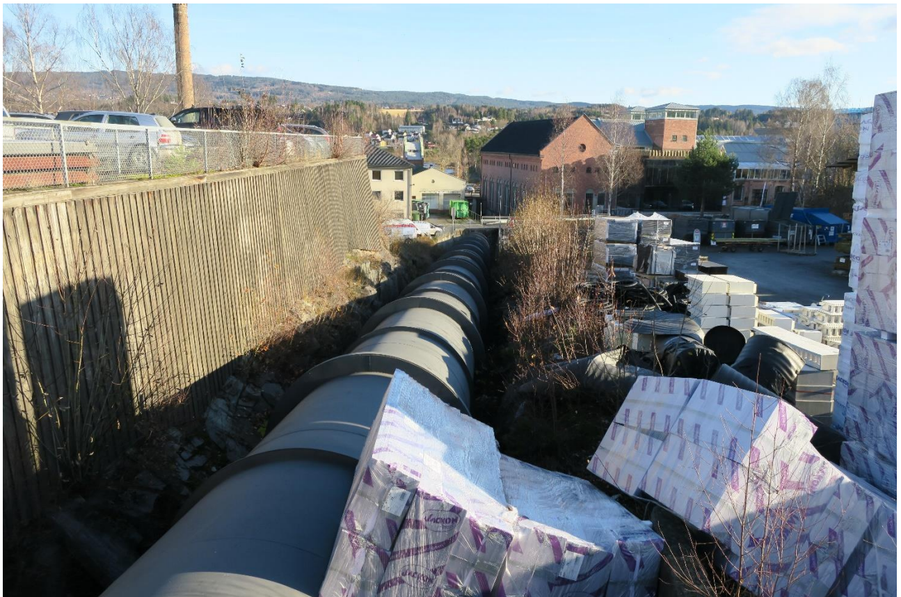
Bilde D Rørgate ned mot gamle kraftstasjonen
