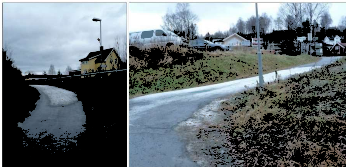
Figur 16: Rampene til kulverten har bratt stigning. Til venstre rampen på vestsiden. Til høyre rampen på østsiden
