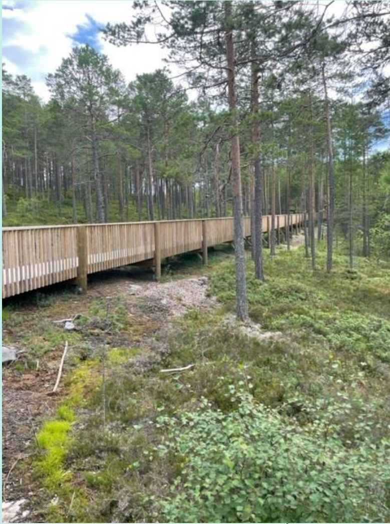
Oppbygget turveg på trebru, Fyresdal (foto Åshild Lie)
