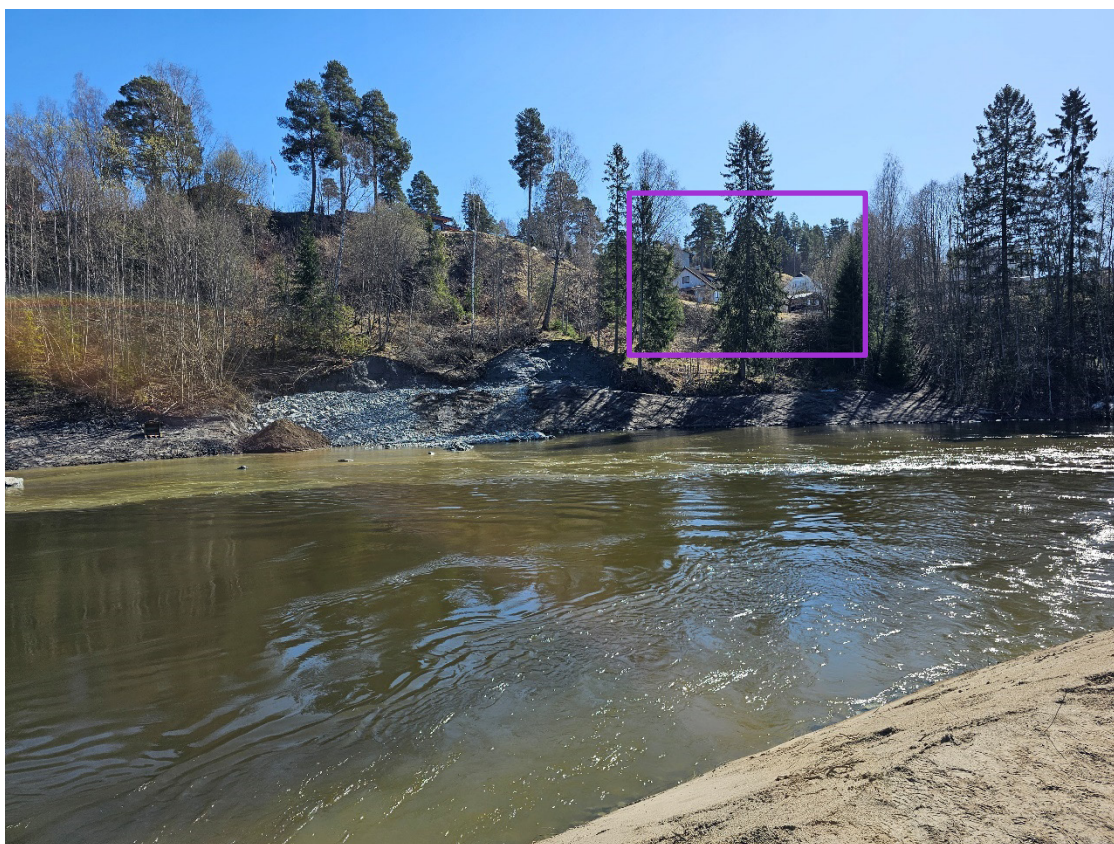
Figur 2-6 Utført erosjonssikring langs Randselva, med Skogfaret 9 i bakgrunnen i lilla [9]
