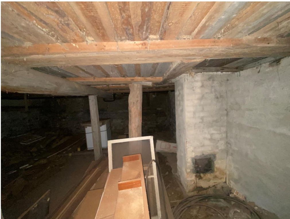
20. Bærende tre søyler i kjeller. Uvisst om det er fra byggeår eller om noen av de er forsterket i etterkant av byggeår.
