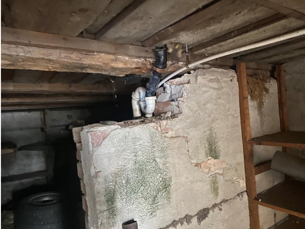
17. Bærende konstruksjon i kjeller fjernet.
