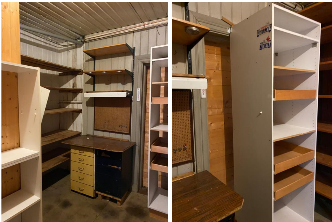
Rom 13 lager/gang med tidligere utgang til trapperom i øst. Opprinnelig panel, himlingsbord, gerikter og listverk. Plater på gulv.
