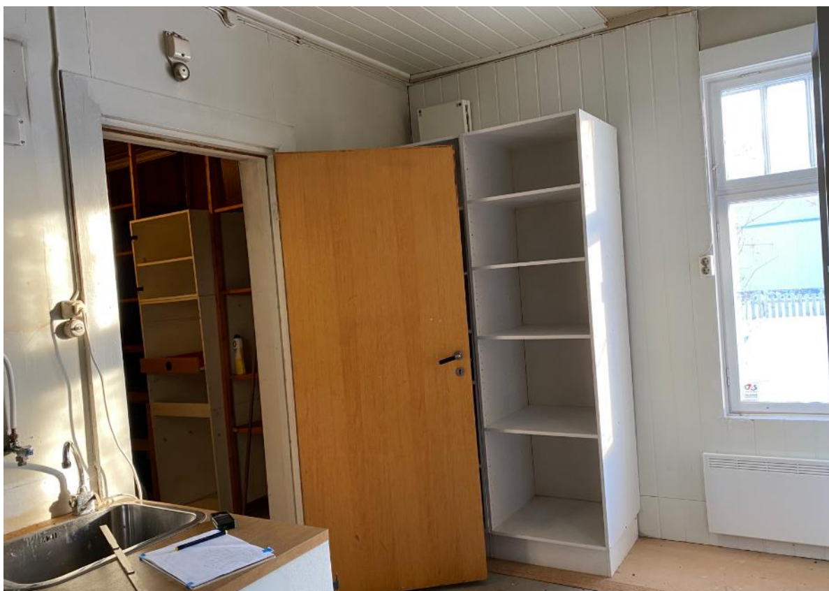
Rom 12. Eldre malt platehimling og linoleum og nye himlingsbord og panel. Sett mot nordøst. Eldre vindu.
