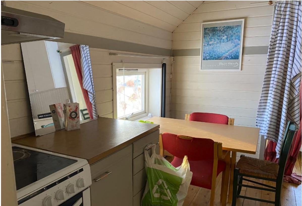
Rom 02. Kjøkken sett mot sørøst. Nytt vindu og nye overflater.
