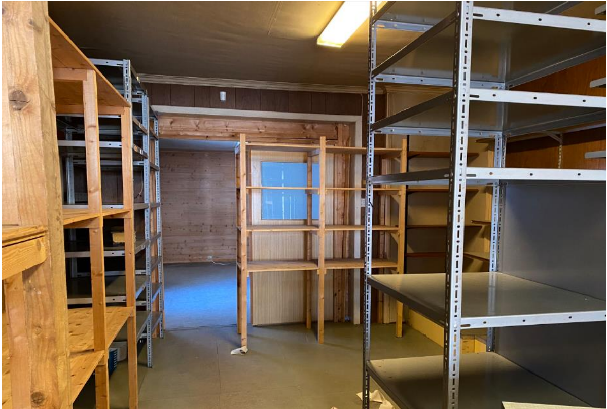
Rom 16 sett mot nord mot rom 17. «Koreapanel», strukket og malt eldre himling, plater på gulv. Døråpning med dobbel dør fra nyere tid.
