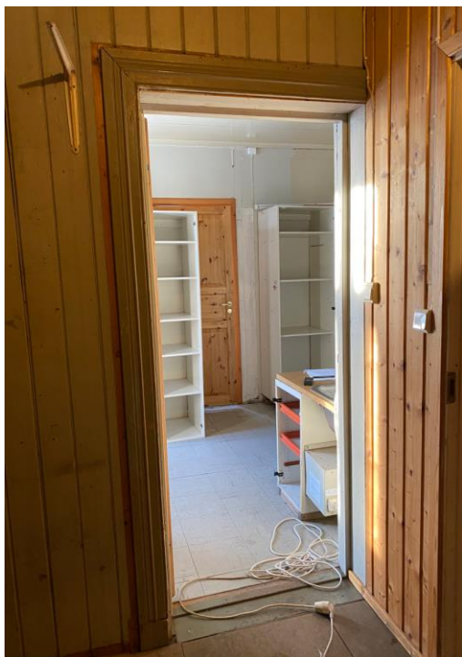
Rom 13 sett mot sør mot rom 12. De opprinnelige geriktene er bevart, men flyttet noe.
