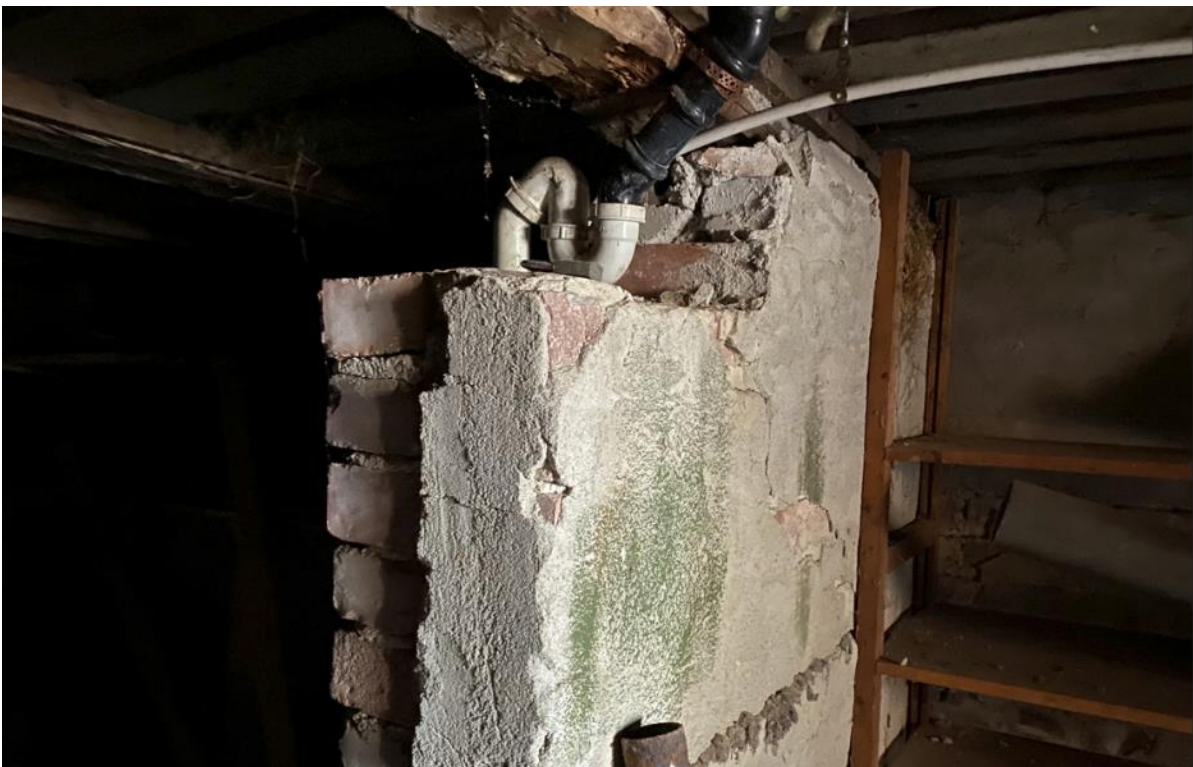
Kjeller midtvegg og yttervegg i slemmet tegl mot nord. Det var kaldt under befaringen og is/snø er synlig.
