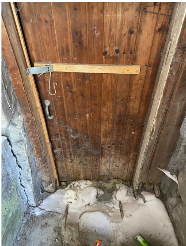
Inngang til kjelleren.
