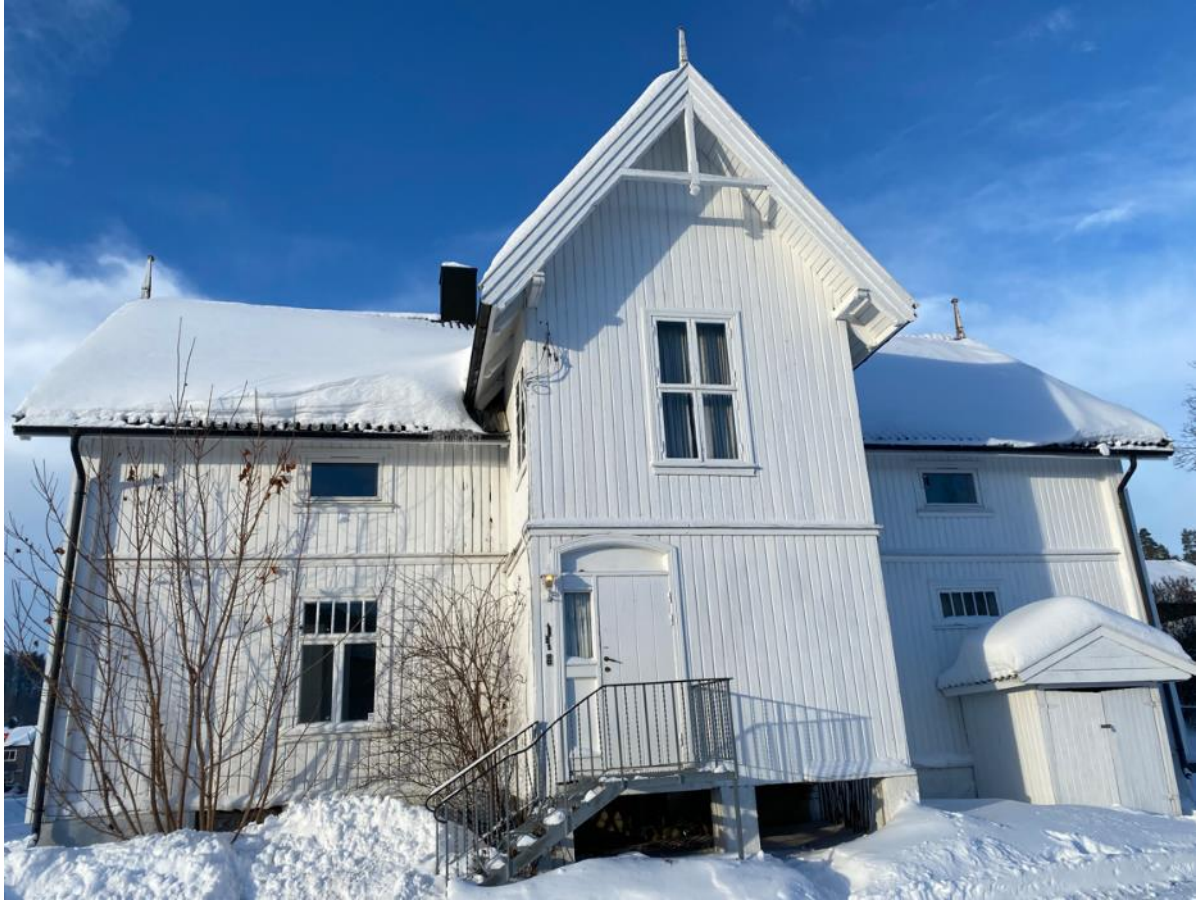
Østfasaden med ny inngangsdør og eldre vinduer. Fint utformede detaljer i sperreender og kryss ved mønet.
