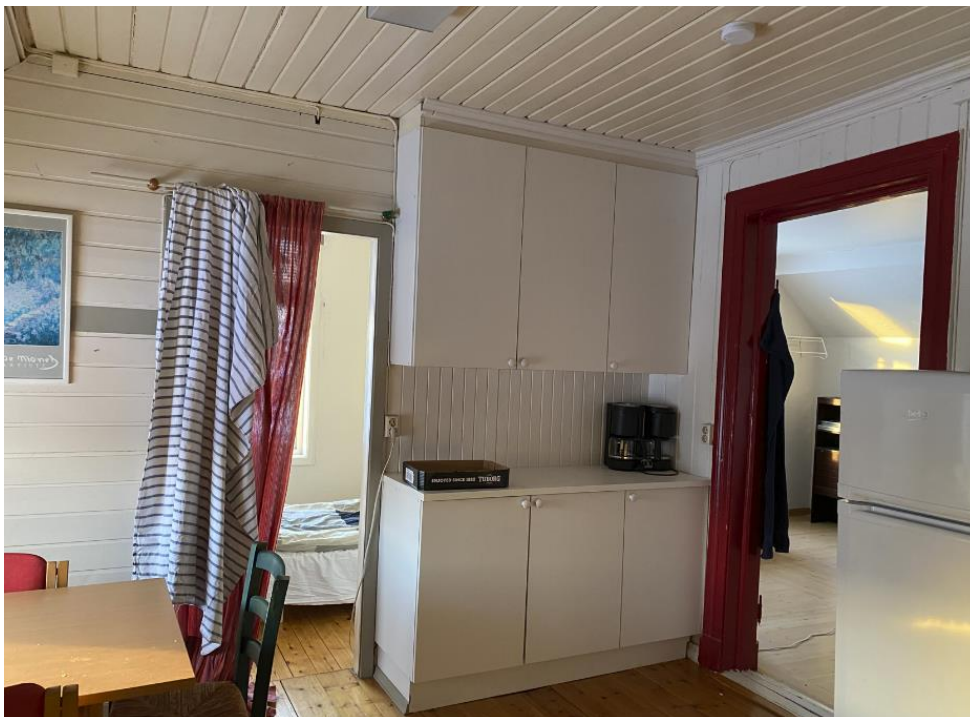
Rom 02. Kjøkken sett mot sør. Eldre panel i himling. For øvrig er det nye overflater.
