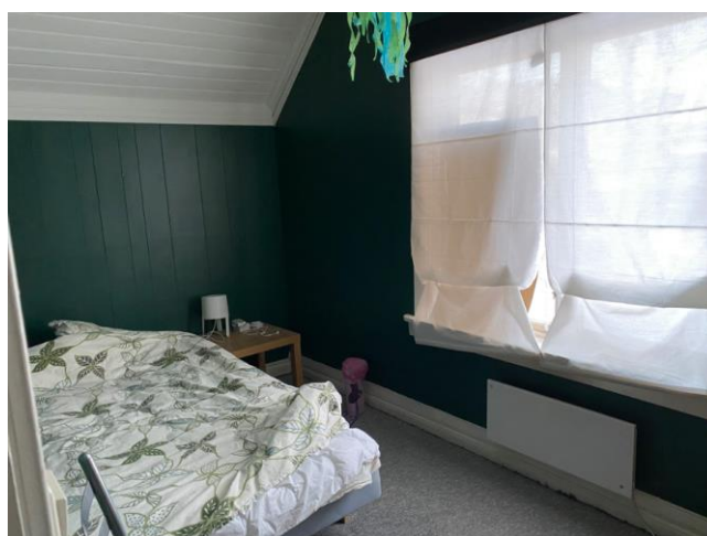
Rom 07 og 08 er soverom. Det er midtpostvinduer fra midten av 1900-tallet. Panel fra ulike perioder og teppe på gulv. Sannsynligvis eldre gulv under.
