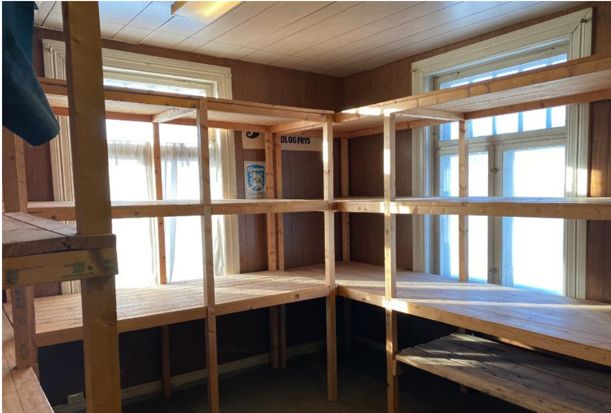
Rom 15 sett mot sørvest. Rommet har vært benyttet som lager. «Koreapanel» på vegger og vekselpanel i himling viser eldre renoveringer fra 1950-70 tallet.
