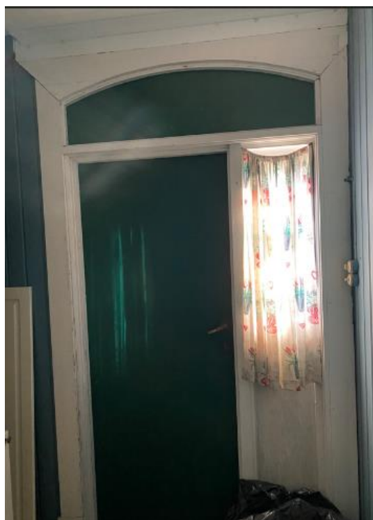
I første etasje i trapperommet er det nytt belegg på gulvet. Inngangsåpningen er bygd om og panel er endret i deler av rommet ifm. at åpningen inn i huset i første etasje er bygget igjen.
