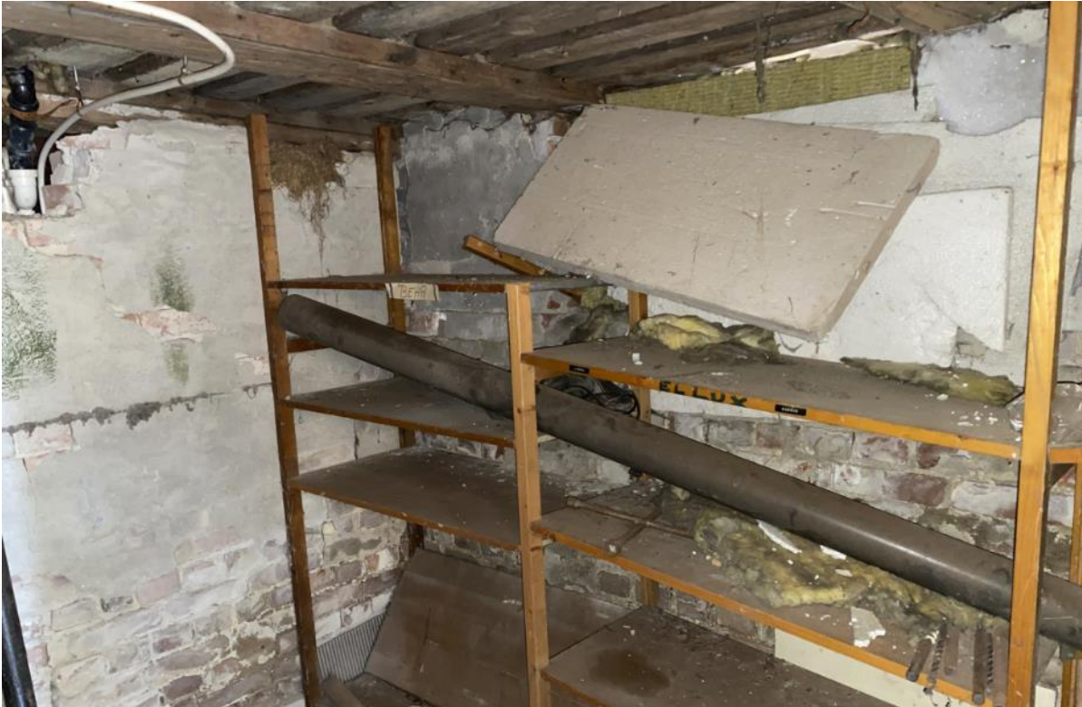
Kjeller midtvegg og yttervegg i slemmet tegl mot nord. Det var kaldt under befaringen og is/snø er synlig.
