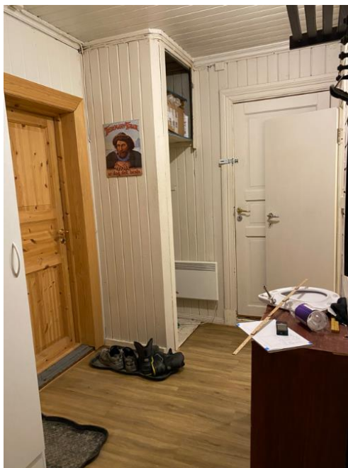
Rom 04, gang med utgang til trapperommet i øst. T.v. sett mot sør mot rom 02 og t.h. sett mot nord mot rom 06. Opprinnelig himling og panel og nye dører, gulvbelegg og panel på andre vegger. Luke til loft er i garderoben bak forhenget.
