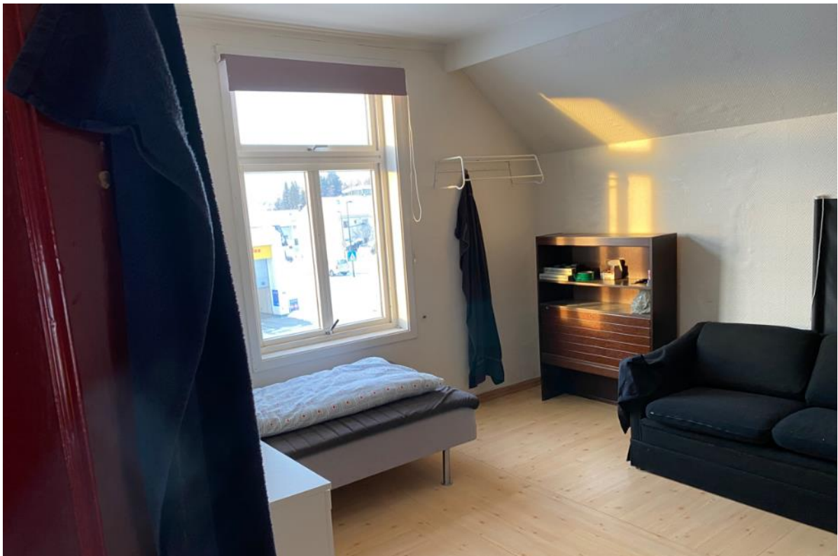
Rom 03 sett mot sørvest. Nyere overflater. Vindu fra 1980-tallet. Sannsynlig at eldre panel og himlingsbord er bevart under det nyere.
