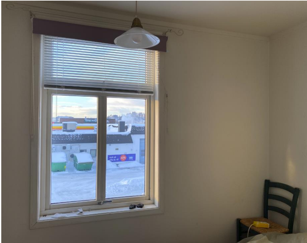
Rom 01. Mot sør. Nye vinduer. Malte palter.
