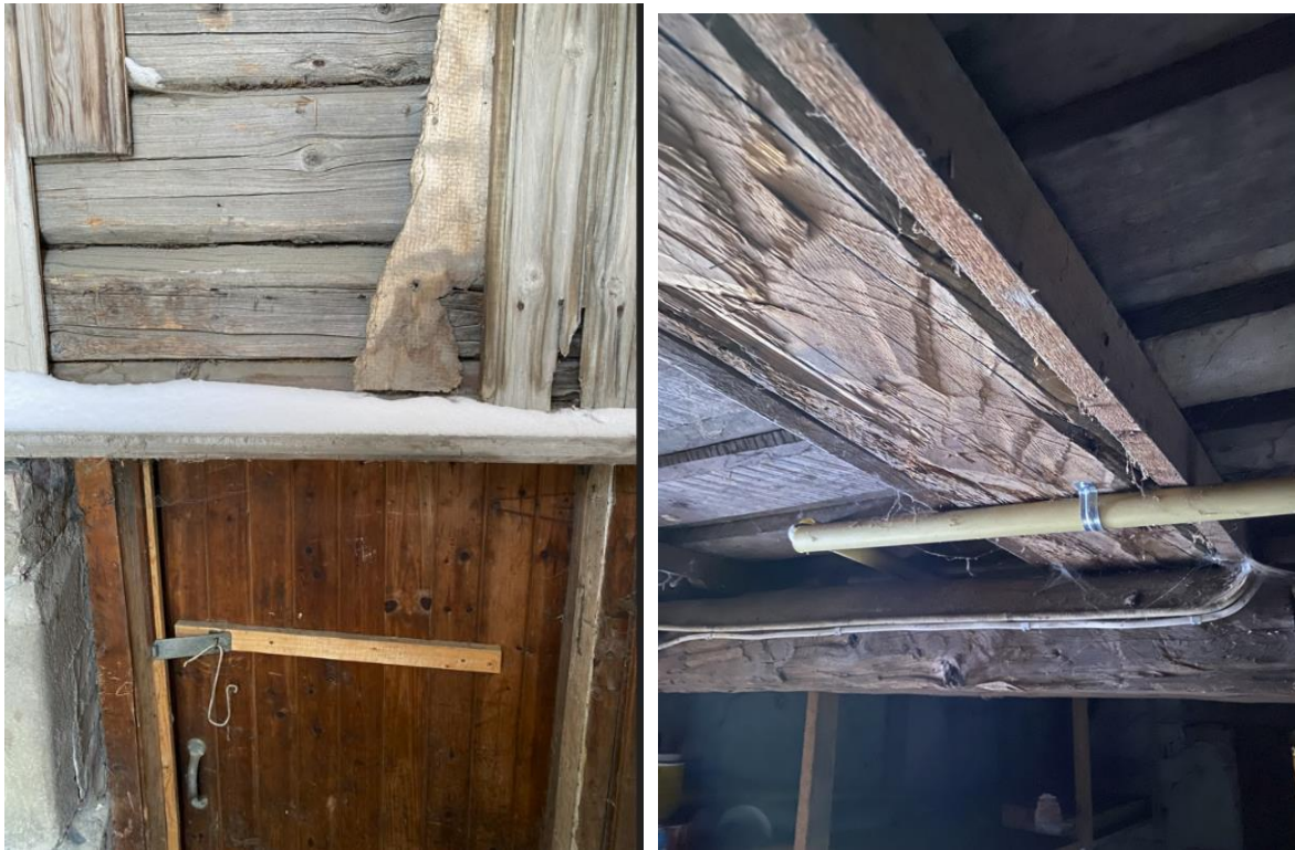
T.v. Tømmerveggen er synlig ved nedgangen til kjelleren. T.h. Grovt tilhogde gulvbjelker.
