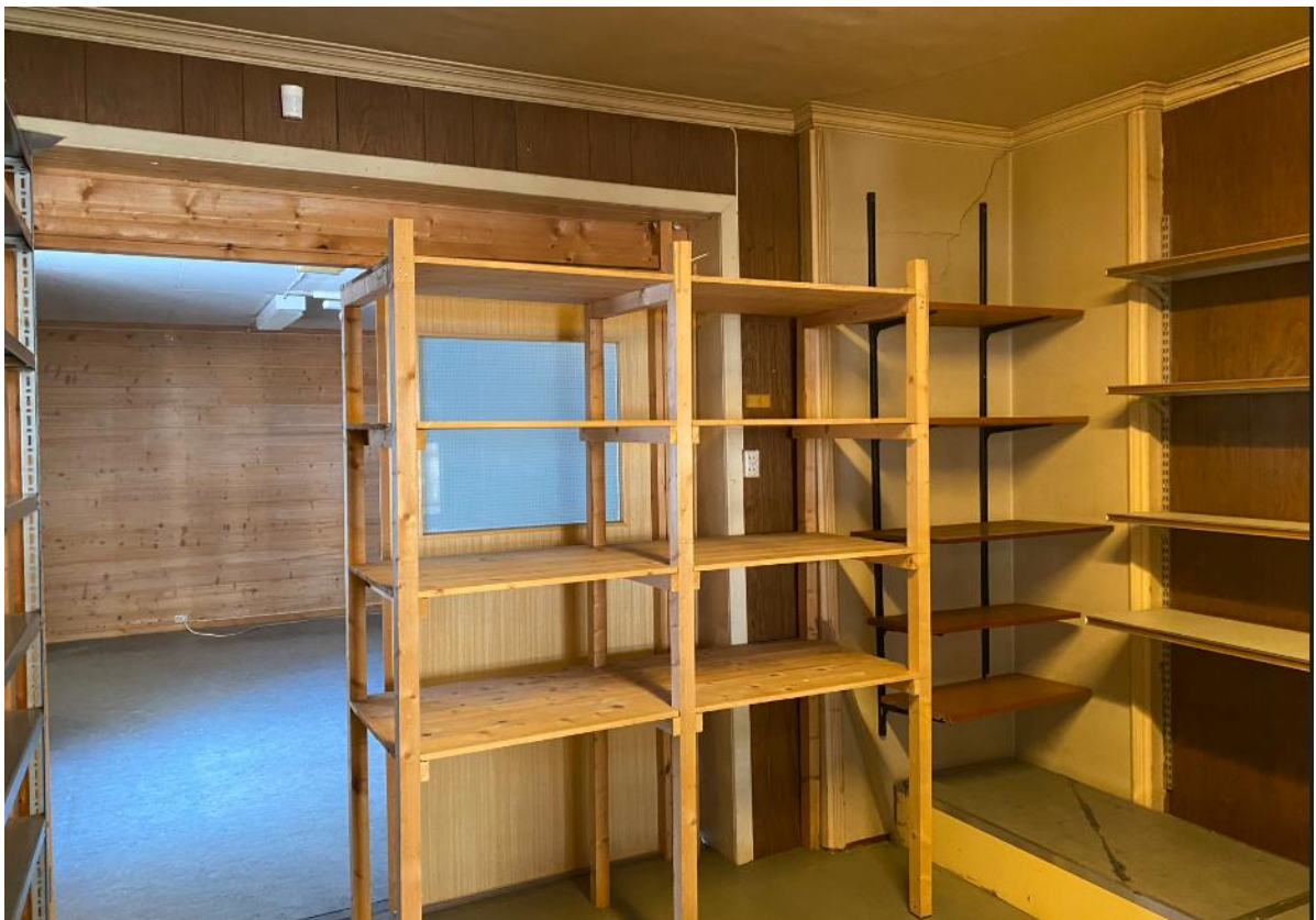
Rom 16 med gammelt listverk i tak og ved pipemuren. Nyere listverk ved døråpning.
