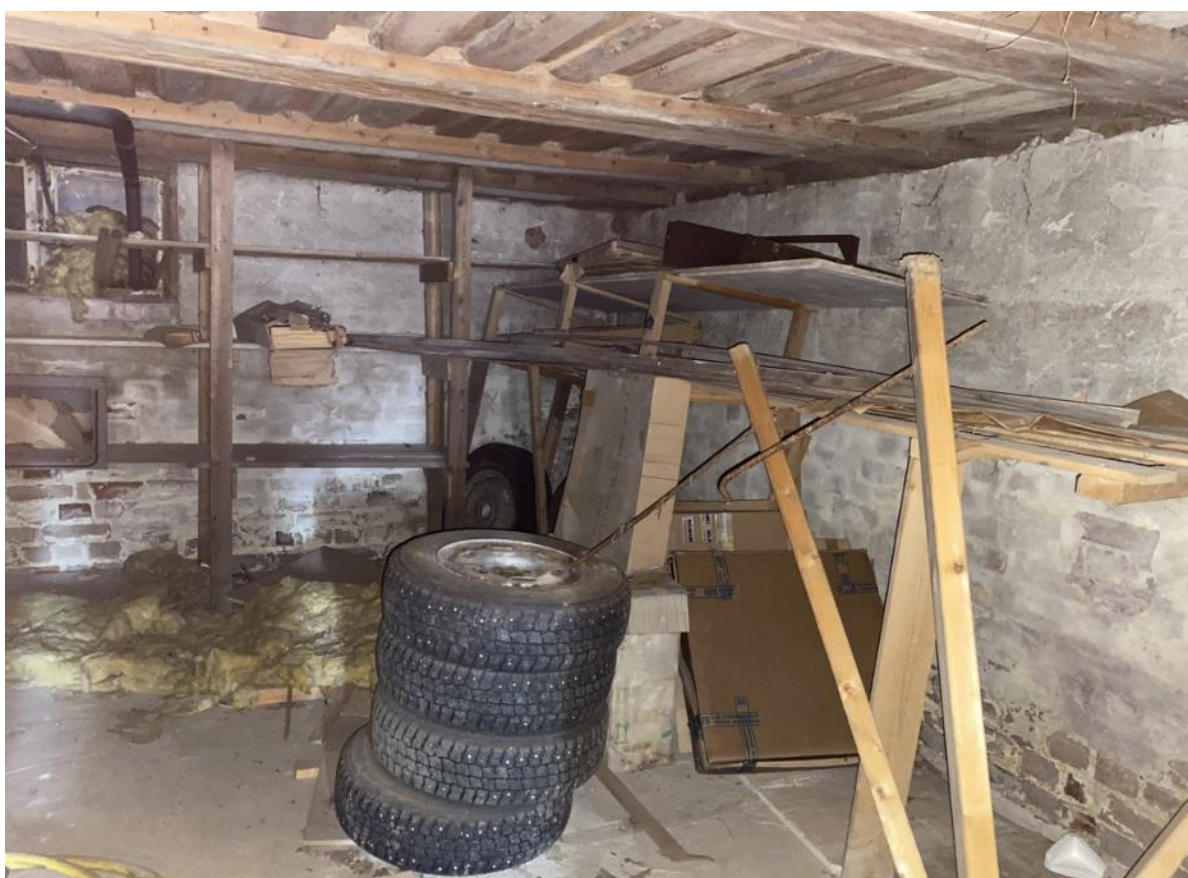
Kjellerrom med stubbloftsplanker synlige i taket.
