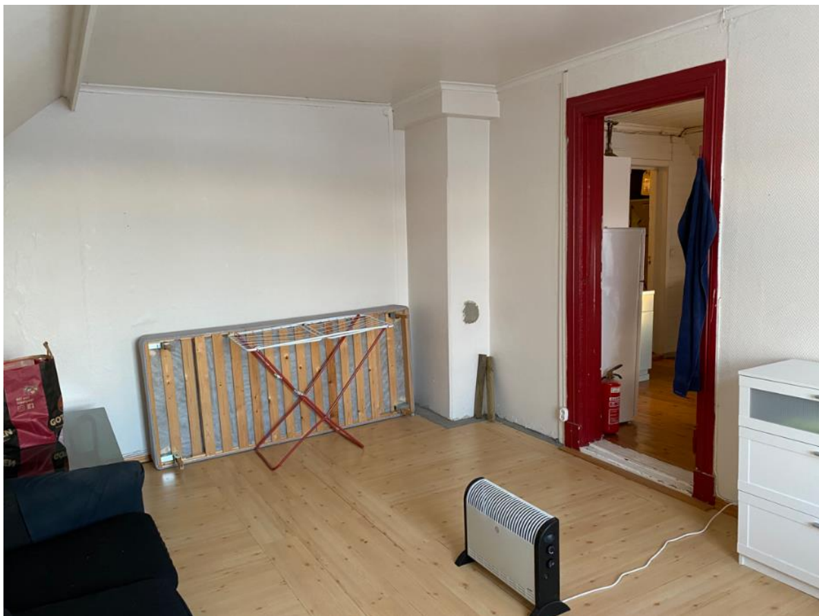
Rom 03, soverom, sett mot nordøst. Opprinnelige gerikter og døråpning.
