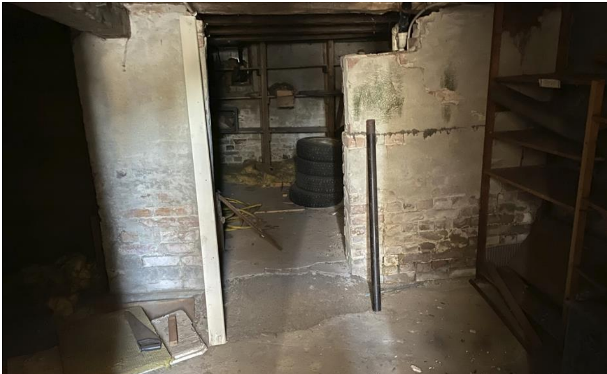
Kjeller sett fra kjellernedgang mot vest. «Hjerteveggen» som utgjør midtre bærelinje sees rett fram. Teglstein er tatt ned i flere av veggene for framføring av rør.
