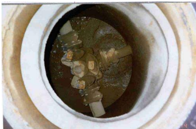
Figur 6 Eksisterende vannkum 1116 i Vesterngata. Utskifting anbefales
