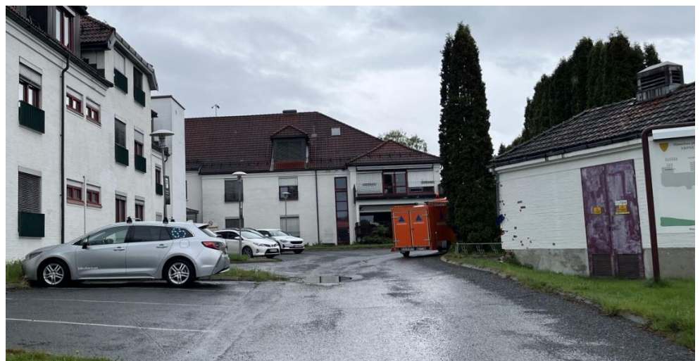
Figur 18: Trafostasjonen ved dagens sykehjem (til høyre i bildet) har middels verneverdi (Kilde: foto fra Arkitema/COWI).
