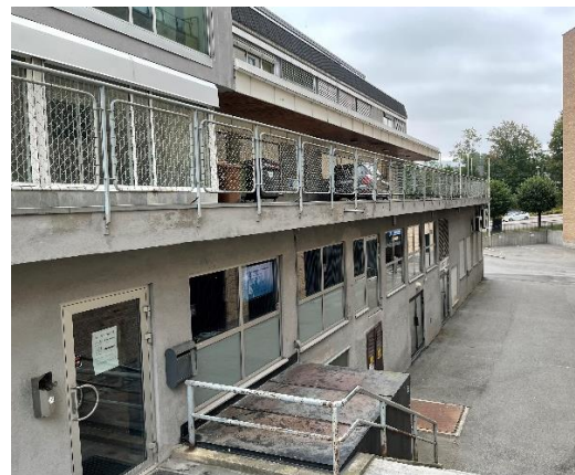
Figur 30: Sentrumspassasjen dagens situasjon
