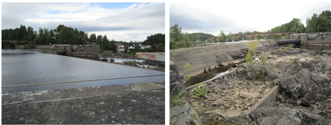
Figur 2-2: Dam Hønefossen fra oppstrøms side (venstre bilde) og nedstrøms side
