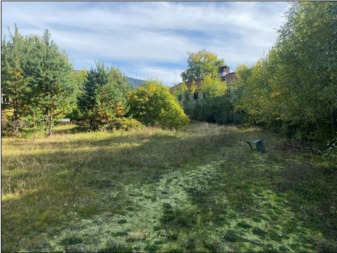
Figur 4-18: Tidligere Olsviken aldershjem ligger sentralt i området og skal rives. Institusjonen er nedlagt og området rundt bygningsmassen er under sterk gjengroing. Foto: Sweco Norge.
