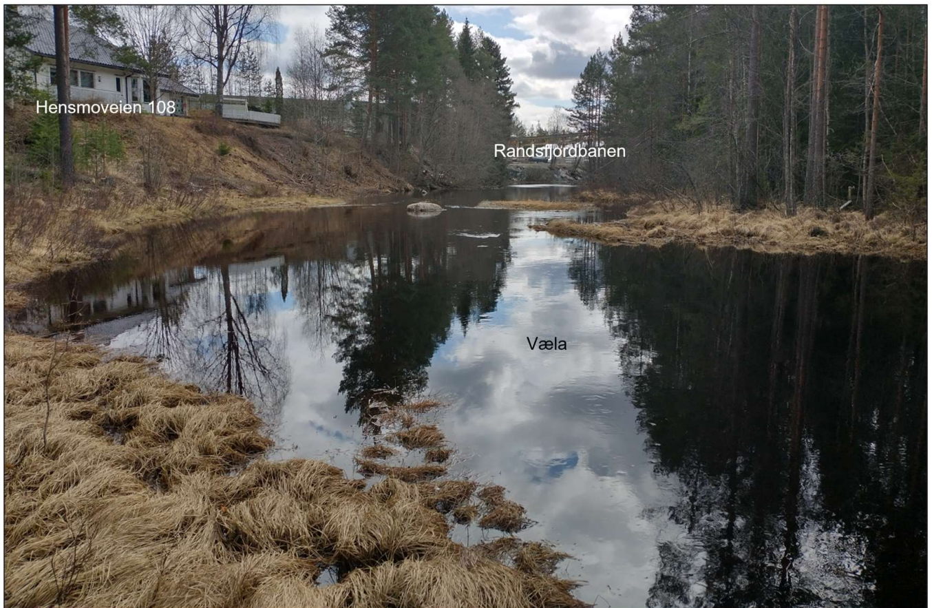
Figur 25 Bildet viser sørlig del av Væla med noe tiltagende fall og godt definerte bredder. Tilliggende areal ligger godt sikret mot flom og det observeres ingen tegn til erosjon.
