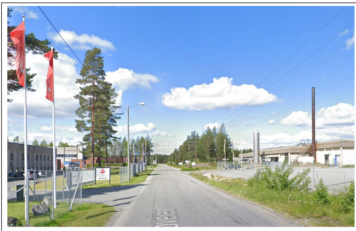
Figur 5: Hensmoveien på strekningen sørvest for E16, nordvestlig retning mot Hensmoen nord. Veien er opparbeidet som typisk atkomstvei for industrivirksomhet med høy andel tunge kjøretøy og få gående og syklende. Foto i nordvestlig retning fra google maps (2019).
