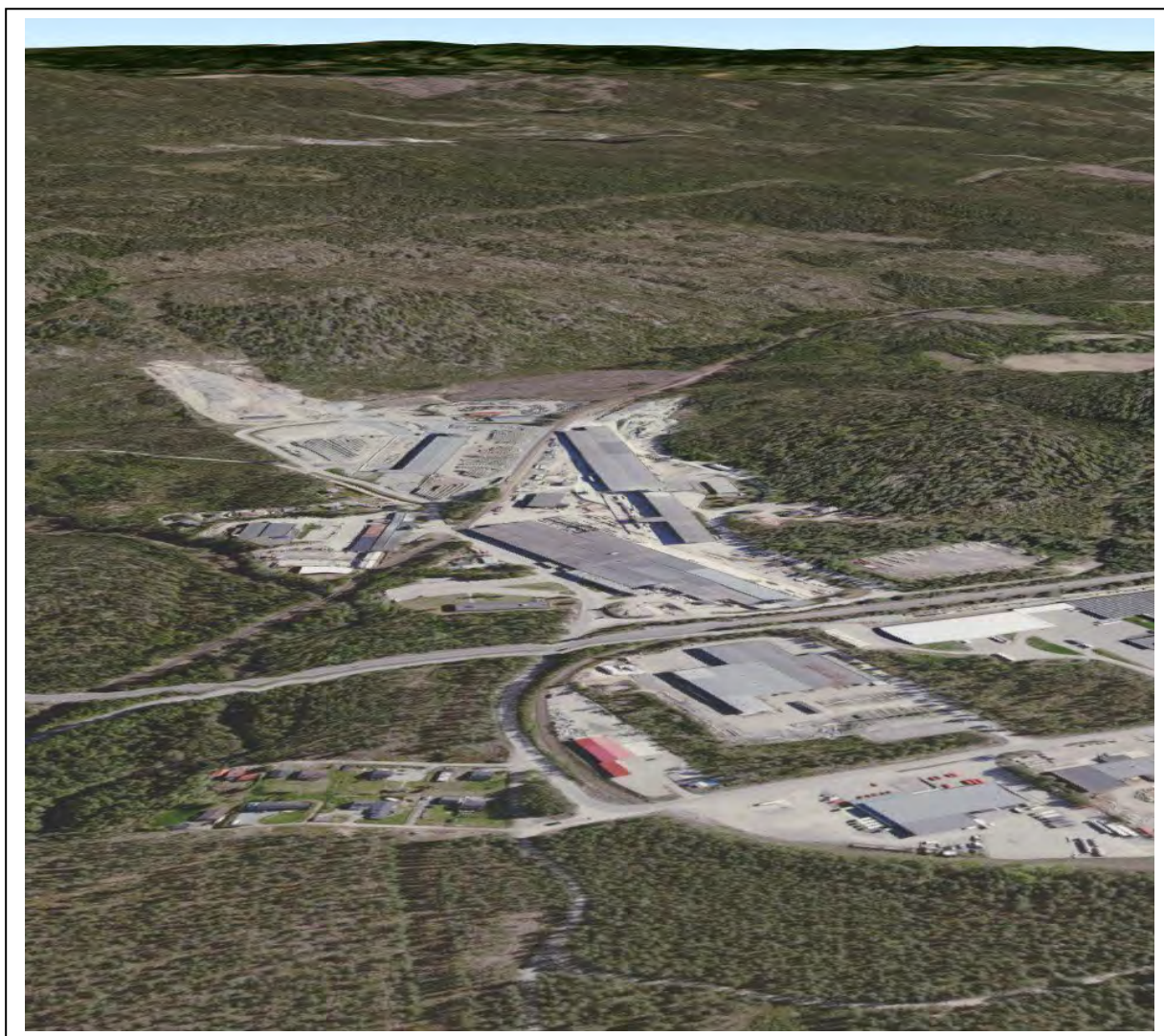
Bilde fra Norgebilder-3D, viser Hensmoen nord sett fra sør mot nord.
