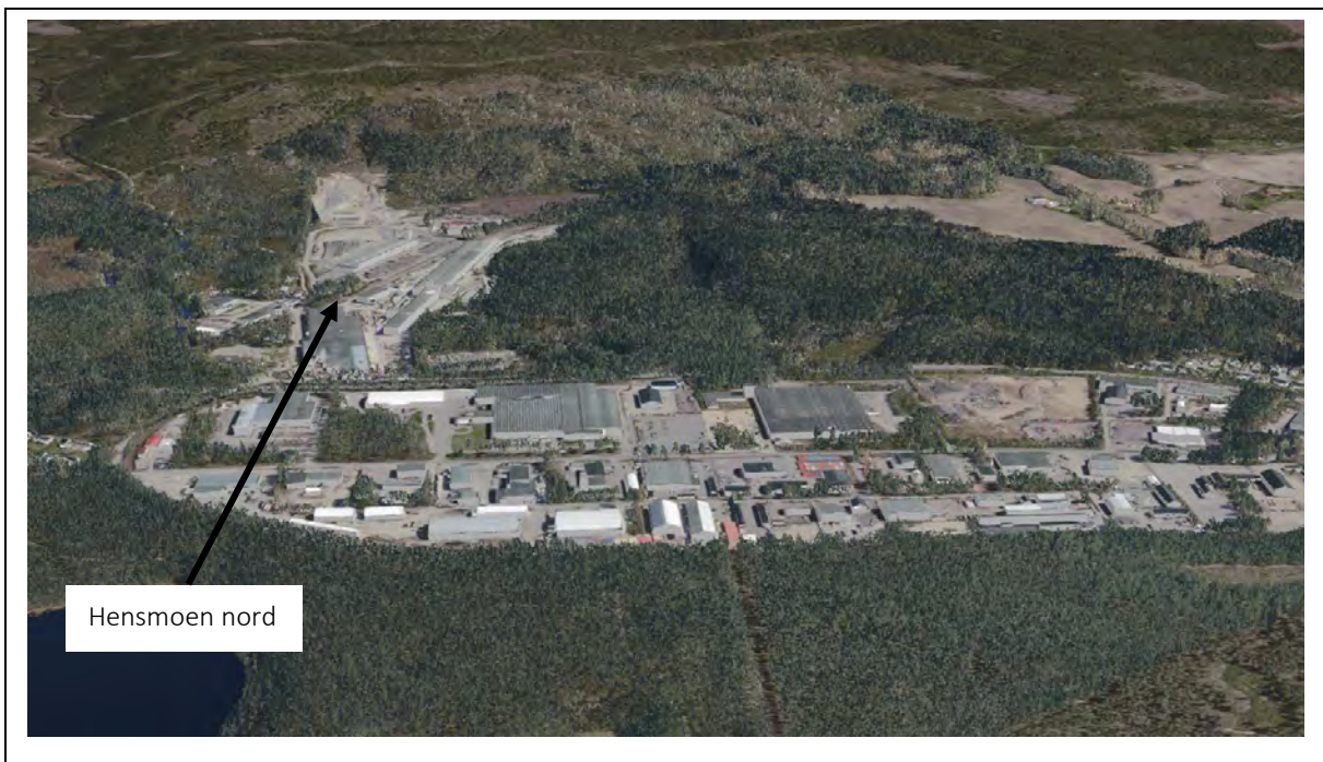
Figur 2.3.3: Dagens situasjon i planområdet. Bildet er tatt fra 3D modellen og viser industriområdet på Hensmoen med lokaliseringen av Hensmoen nord. Planområdet ligger nord for E16.
