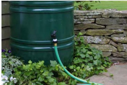
Figur 4: Takvann samles i dunker for gjenbruk av overvann ved behov. ( www.bnriverkeeper.org )
