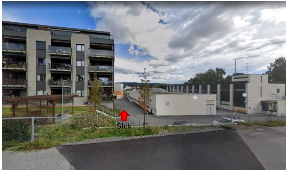
Figur 7: Google maps - Street view over Telegrafalleen 2 og nabobygg. Begge bygg har fall mot markert sluk.
