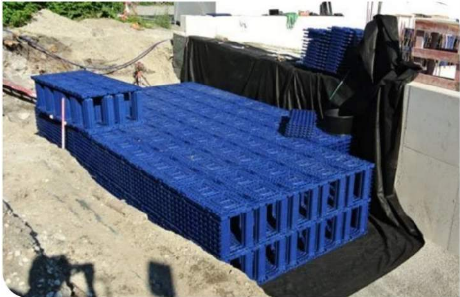
Figur 15: Eksempel med bruk av Q-Bic plus kassetter for overvannshåndtering. Foto lånt av wavin.
