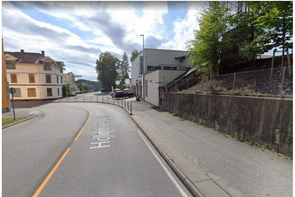
Figur 18: Etablering av blindvei i Holmboes gate i krysset mot Stangs gate.
