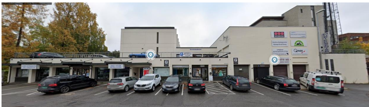
Figur 12 - Eksisterende bebyggelse innenfor planområdet sett fra Holmboes gate(maps.google.no)
