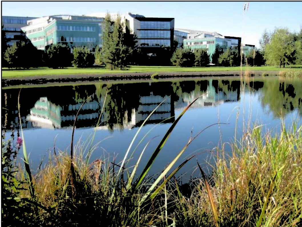
Vannspeil som estetisk element i et næringsområde (Fornebu i Bærum kommune). Vannspeilet tilføres kun takvann og all transport av vann skjer med gravitasjon. Ingen rensing eller resirkulering av vannet.
