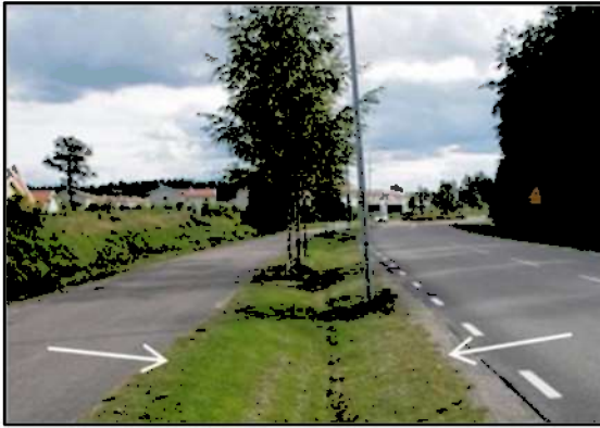
Eksempler på infiltrasjon av overvann fra trafikkerte arealer (veier og plasser). Infiltrasjon langs vei til venstre og sentral løsning for oppsamlet veivann til høyre.
