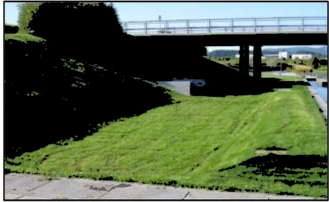
Eksempler på infiltrasjon av overvann fra trafikkerte arealer (veier og plasser). Infiltrasjon langs vei til venstre og sentral løsning for oppsamlet veivann til høyre.
