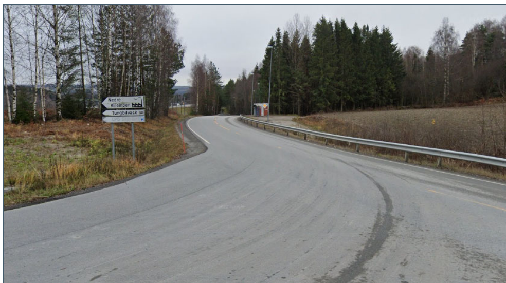
Figur 9-1 Siktforholdene ved venstresving fra Follummoveien. Kilde: google.com/maps
