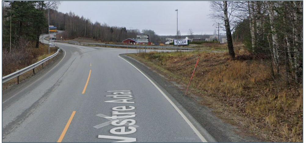
Figur 9-2 Siktforholdene i krysset Follummoveien/Vestre Ådal, sett fra Vestre Ådal øst for krysset. Kilde: google.com/maps
