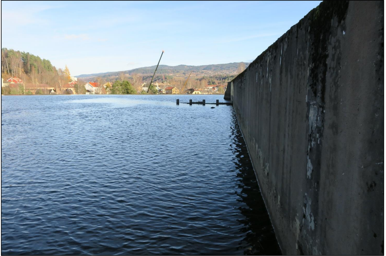
Bilde A Flomvern oppstrøms dammen
