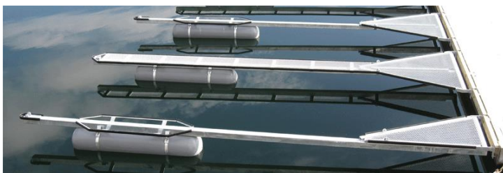
Eksempel på utforming utliggere i småbåtanlegg og gjestebrygge
