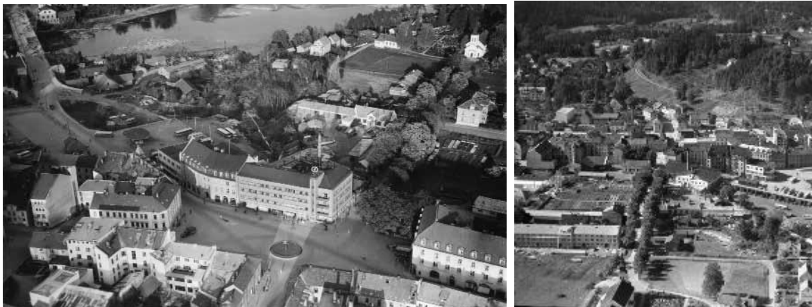
Søndre Torg med Kirkegata og Fossveien/Hønefoss bru som sentrale forbindelseslinjer (Otto Hansen/Ringerike bibliotek 1951) og forbindelsen mellom kirken og St. Olavs gate (Buskerud fylkesfotoarkiv)
