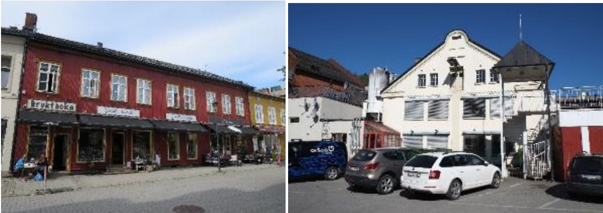
Søndre torg 8 og bakeribygningen i bakgården (NIKU 2018)
