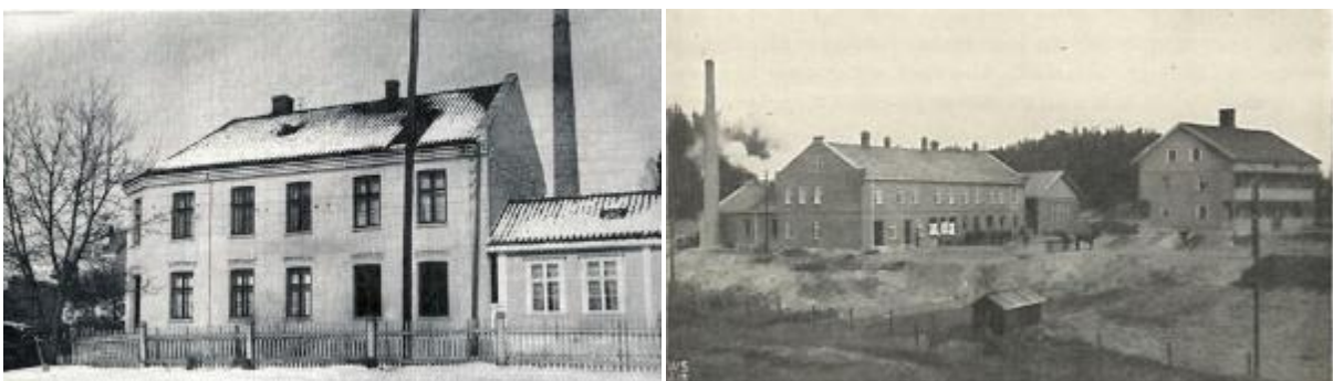
Hønefoss meieri i Hammerbrogata 9 og det nye anlegget oppført i 1914 (Hønefoss – byens historie)
