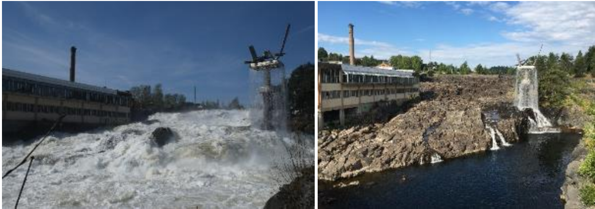
Hønefossen med og uten vannføring (NIKU mai/juli 2018)
