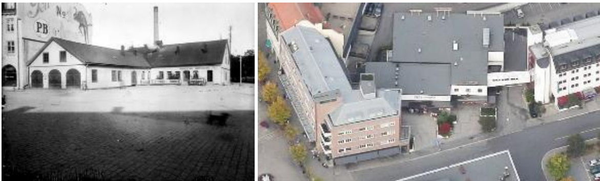
Hønefoss bryggeri før 1930 og Bryggerigården oppført på torget i 1975 og med deler av bryggeriet i bakkant (1881)
