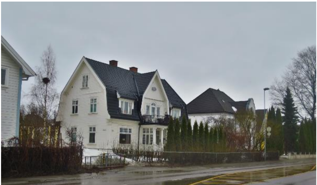
Verneverdig Løkka-bebyggelse langs Kongens gates østside (NIKU 2018)
