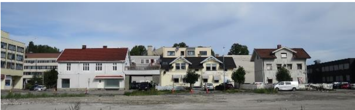
Trehusbebyggelsen ut mot Sundgata er en husrekke i sveitserstil oppført i perioden 1875-1899 (NIKU 2018).
