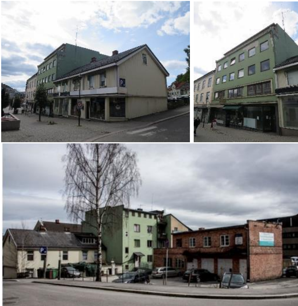
Bebyggelsen i Stabells gate 4 med Hygengården, funksisbygget og bakgården (NIKU 2018)
