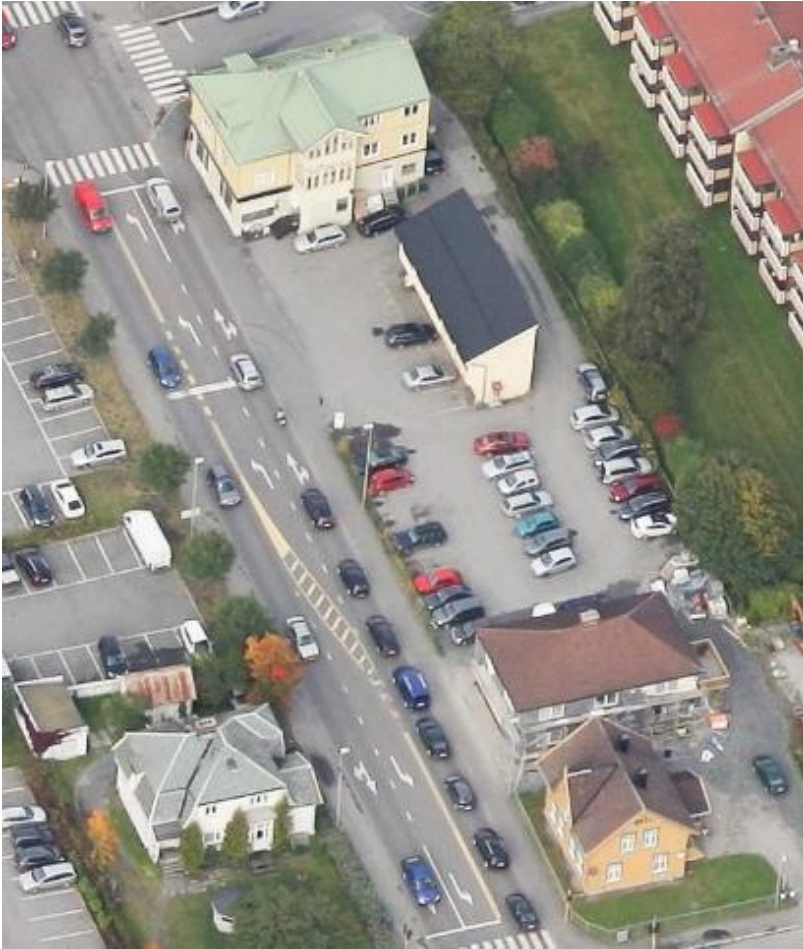
Kong Rings gate 12, Kirkegata 9 og Kongens gate 10 og 12 som kulturmiljø og mulig utgangspunkt for hvordan denne delen av Kongens gate kan videreutvikles (1881)
