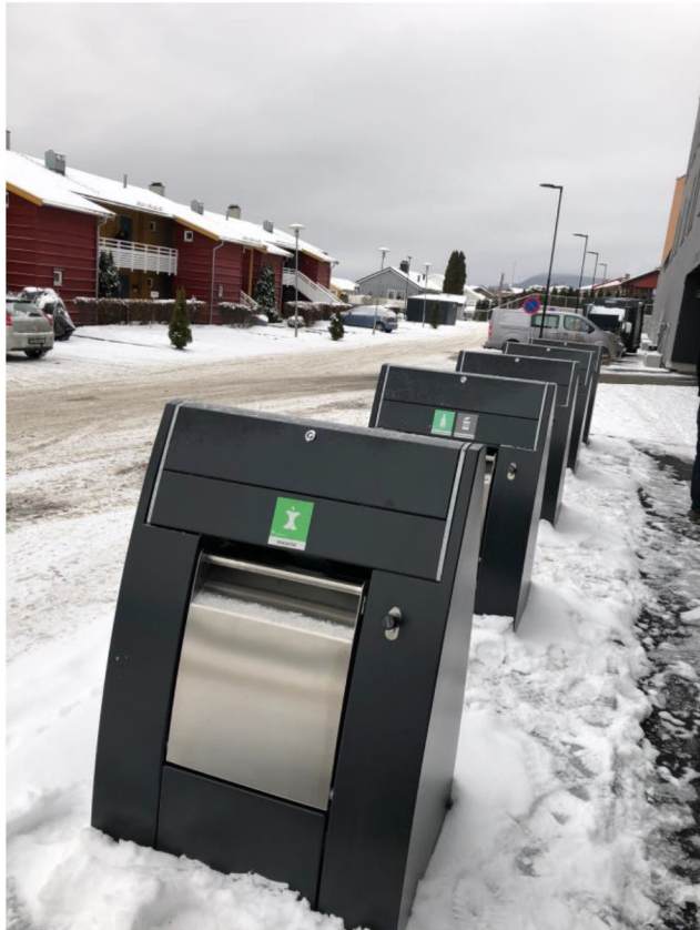
Nedgravd løsning kildesortering ved Heradsbygda omsorgssenter, komprimator i bakgrunnen. Foto: Ringerike kommune
