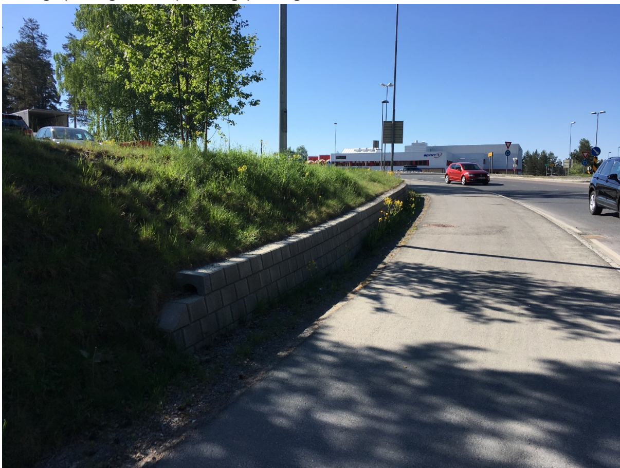
Bilde: Fortau langs fv.290 ved rundkjøring med E16, sett fra nord.
