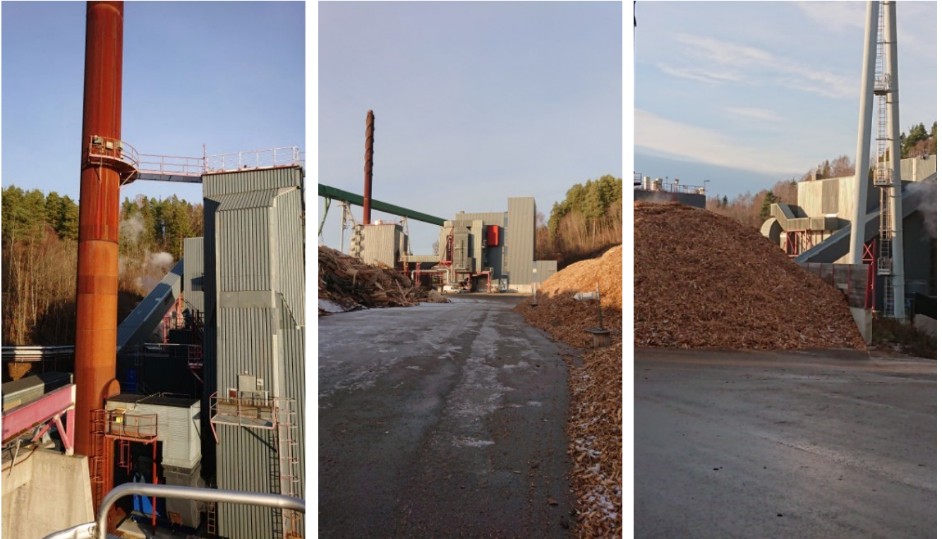
Figur 17 Vardar Varme sin energisentral på Follum (Kilde: vardar.no)
