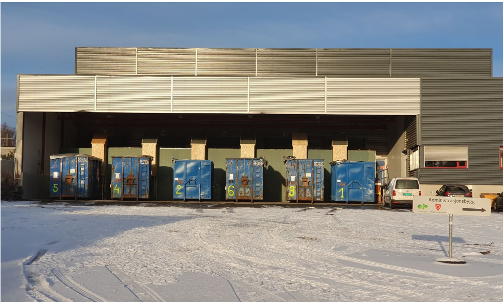
Figur 7 Tørrking av biomasse i containere tilknyttet overskuddsvarme i form av tørr luft rundt 35 - 40 °C fra KV Hønefoss (Kilde: Varma)
