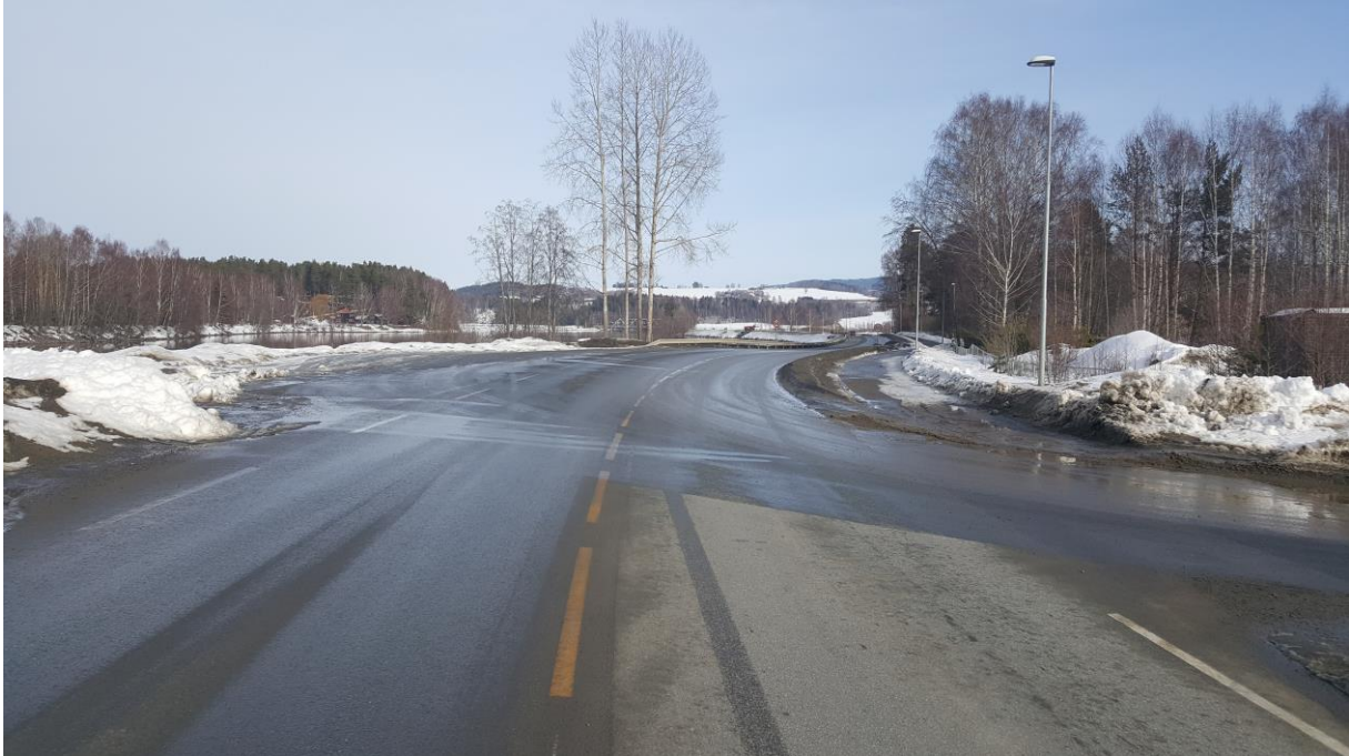
Figur 21 Fv 2854 ved innkjøringen til anlegget
