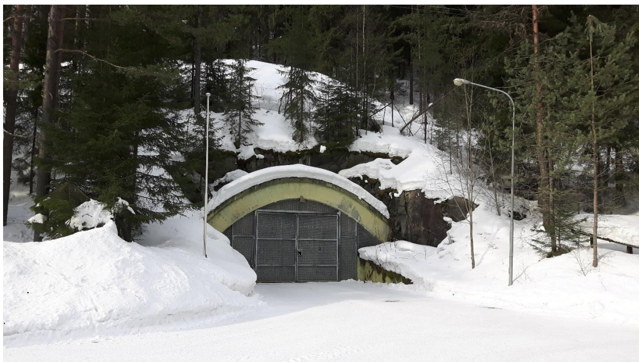
Tunnelåpningen på fjellanlegget.
