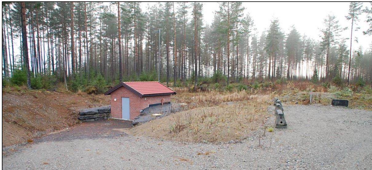
Figur 22 Eksisterende pumpestasjon for spillvann – punkt for tilknytning av ny infrastruktur.
