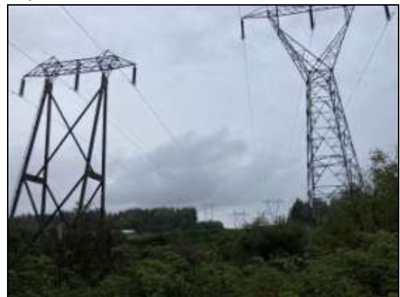
Kraftledninger på kryss og tvers på forurensa grunn på gammel fylling (Tyri-myra) er i k-planen vist som Grønnstruktur-formål.
