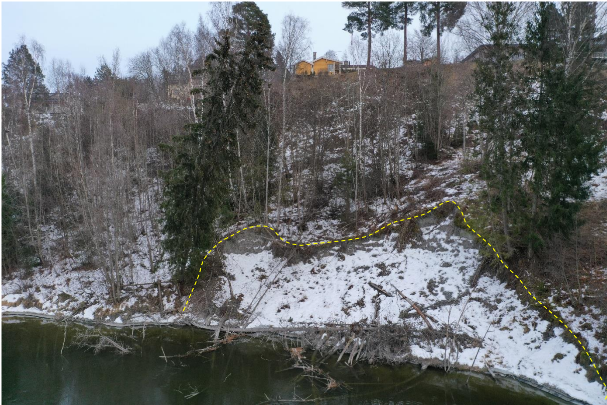
Figur 9: Nyere utglidning i leirige masser i skråningen ned mot elva, nedenfor tomta. Bildet er tatt på med drone på befaring og bakkanten av utglidningen er tegnet med gul stiplet linje.
