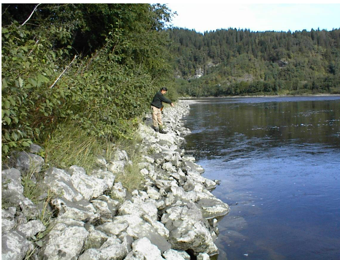
Figur 2-1 Eksempel på ordnet steinlag brukt som erosjonssikring i Stjørdalselva (NVE, 2022).
